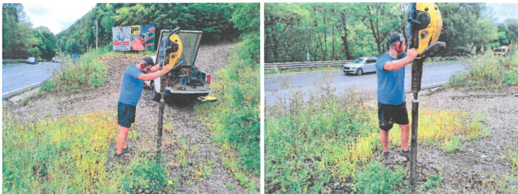
Figura 13. Realizare foraje geotehnice
